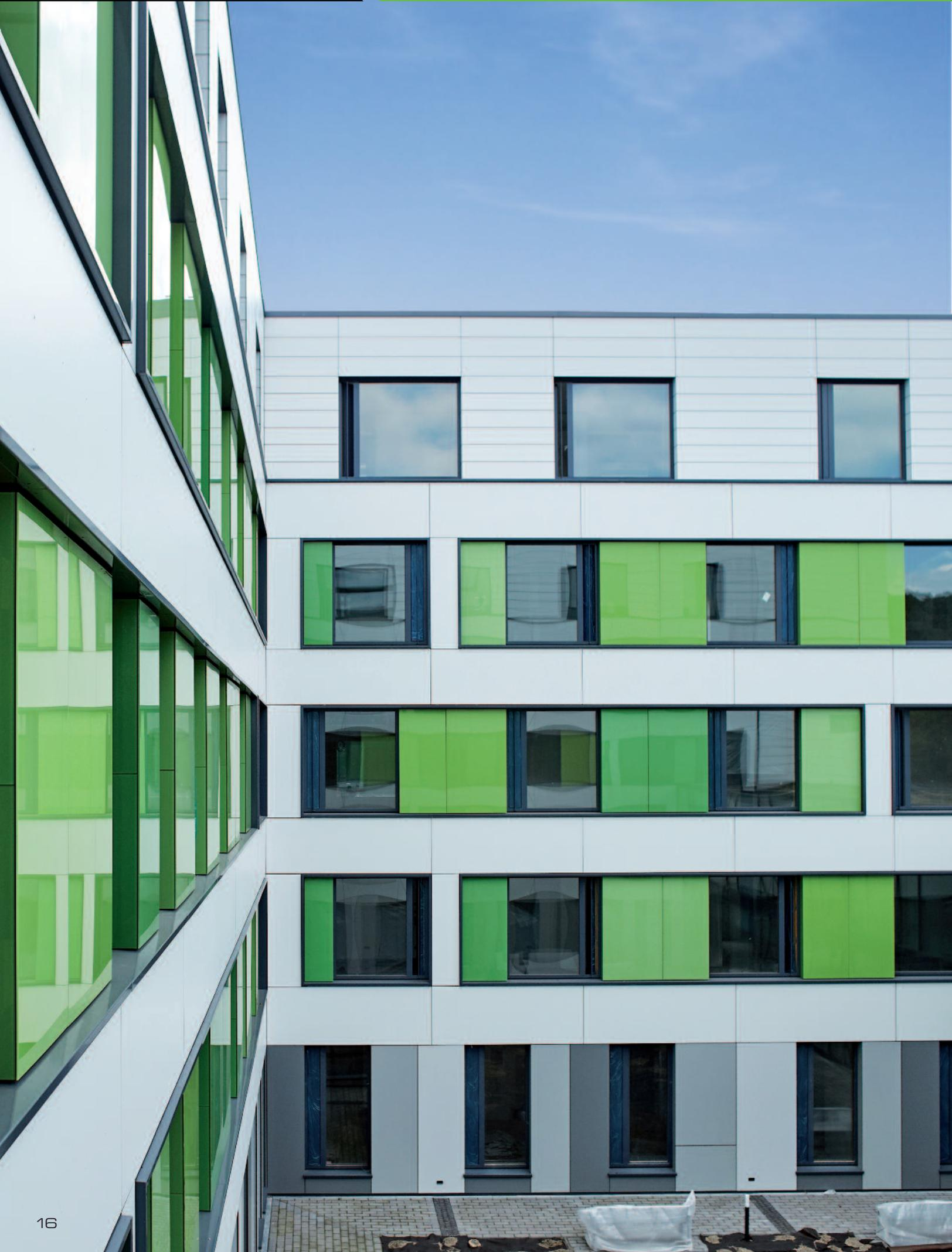
Aus Pfosten-Riegel-Konstruktionen können mehrgeschossige Fassaden gestaltet werden.
